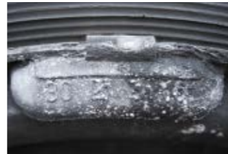
UNBESCHICHTETE GEWICHTE: Kontaktkorrosion der Oberfläche.
